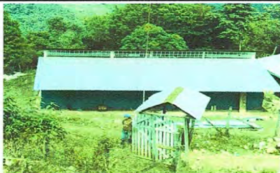
Foto 1: Cubierta de laminas nuevas
