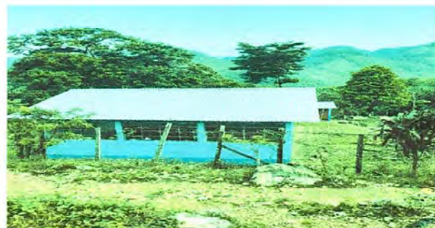
Foto 2: Pintura nuevas en muros
