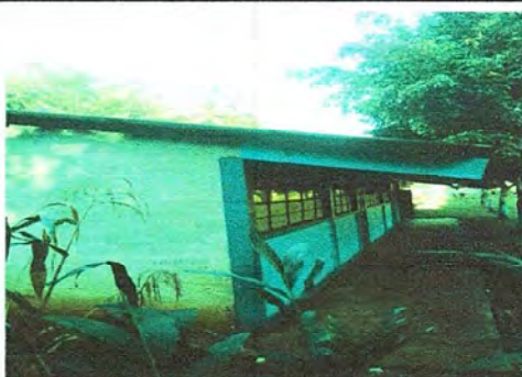
Foto 3: Mantenimiento de piso
