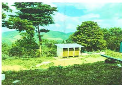
Foto 5: Sustitucion de cubierta de laminas
